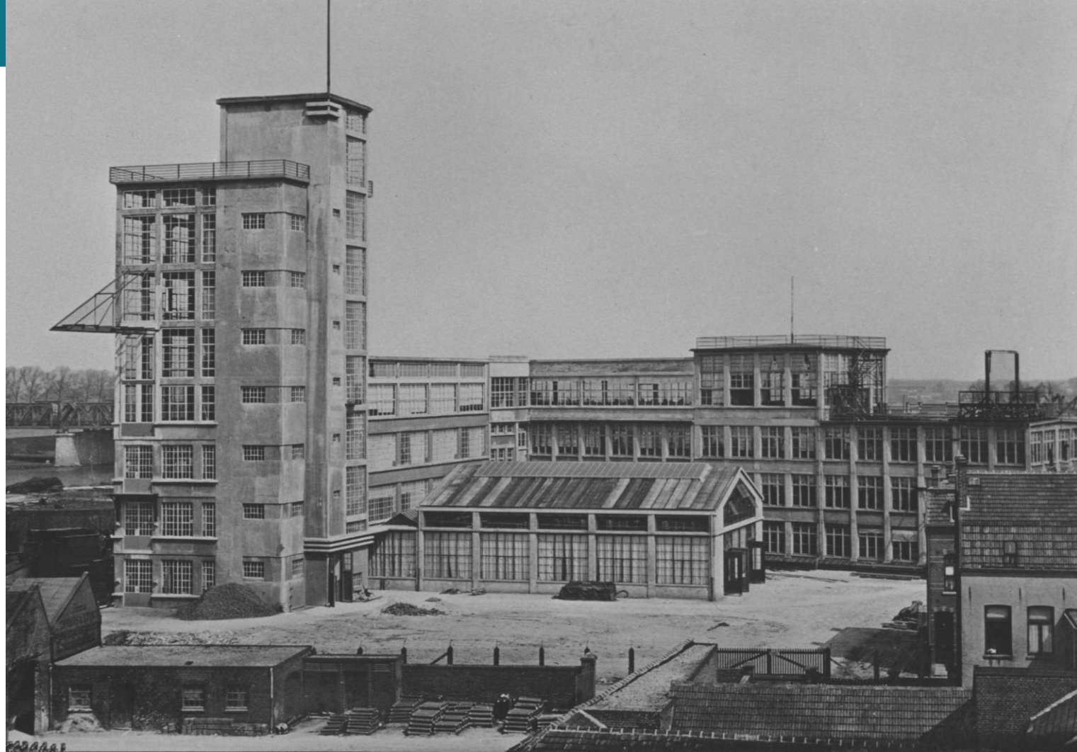
Edificio principal de la fábrica 1930.
