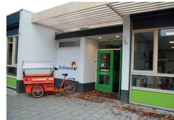
Bij de duurzame renovatie van basisschool De Biezenhof in Halsteren is bewust gekozen voor een integrale aanpak.
