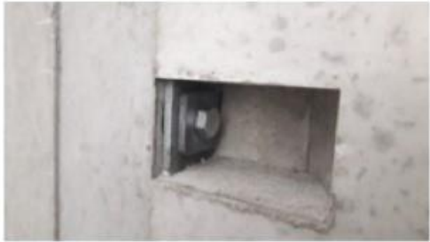
WAND-WAND AANSLUITING
