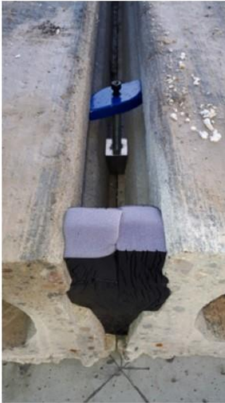
WIG (pilot) TBV VERTICALE FIXATIE
