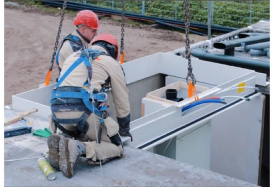
Kant-en-klaar trapgat, met standaard afmetingen Trapschacht met voormonteerde leidingen
