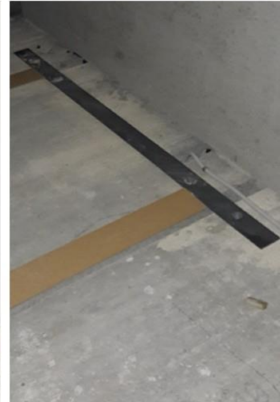
SCHIJFWERKING/STABILITEIT MET STRIPS
