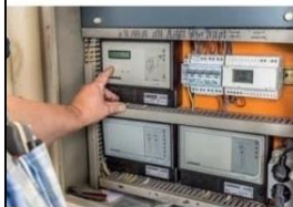
Beter inregelen van verwarming (blokkthermostaat), ventilatie (CO 2 -sturing) en verlichting (daglichtregeling en bewegingssensoren) bespaart 30 tot 40 procent energie.
