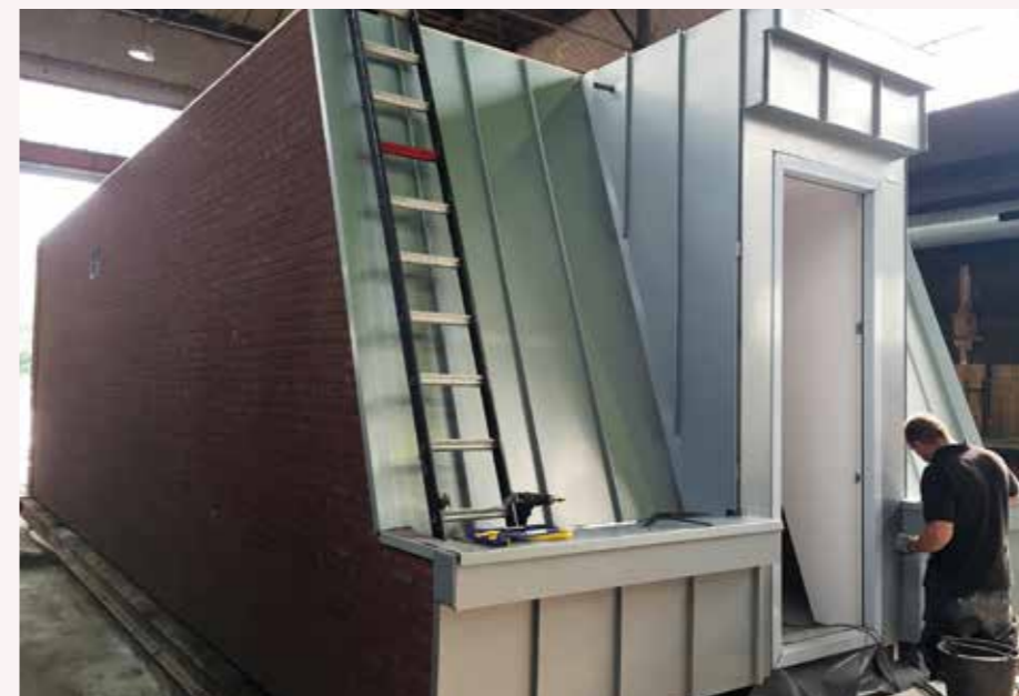
STEIGERLOOS BOUWEN AAN EEN BOVENVERDIEPING (THINKWONEN, DRUNEN).
