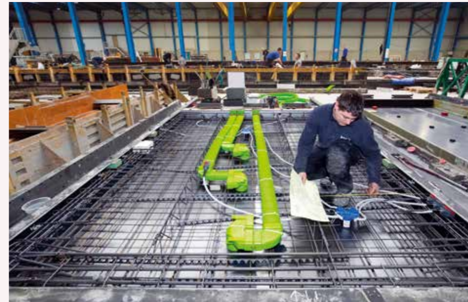
LEIDINGWERK (E,W) WORDT IN DE FABRIEK VOORBEREID (MBS, VIANEN).
