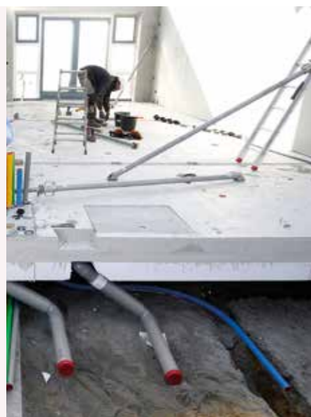
MONTAGE OP DE BOUWPLAATS (MBS, VIANEN).
